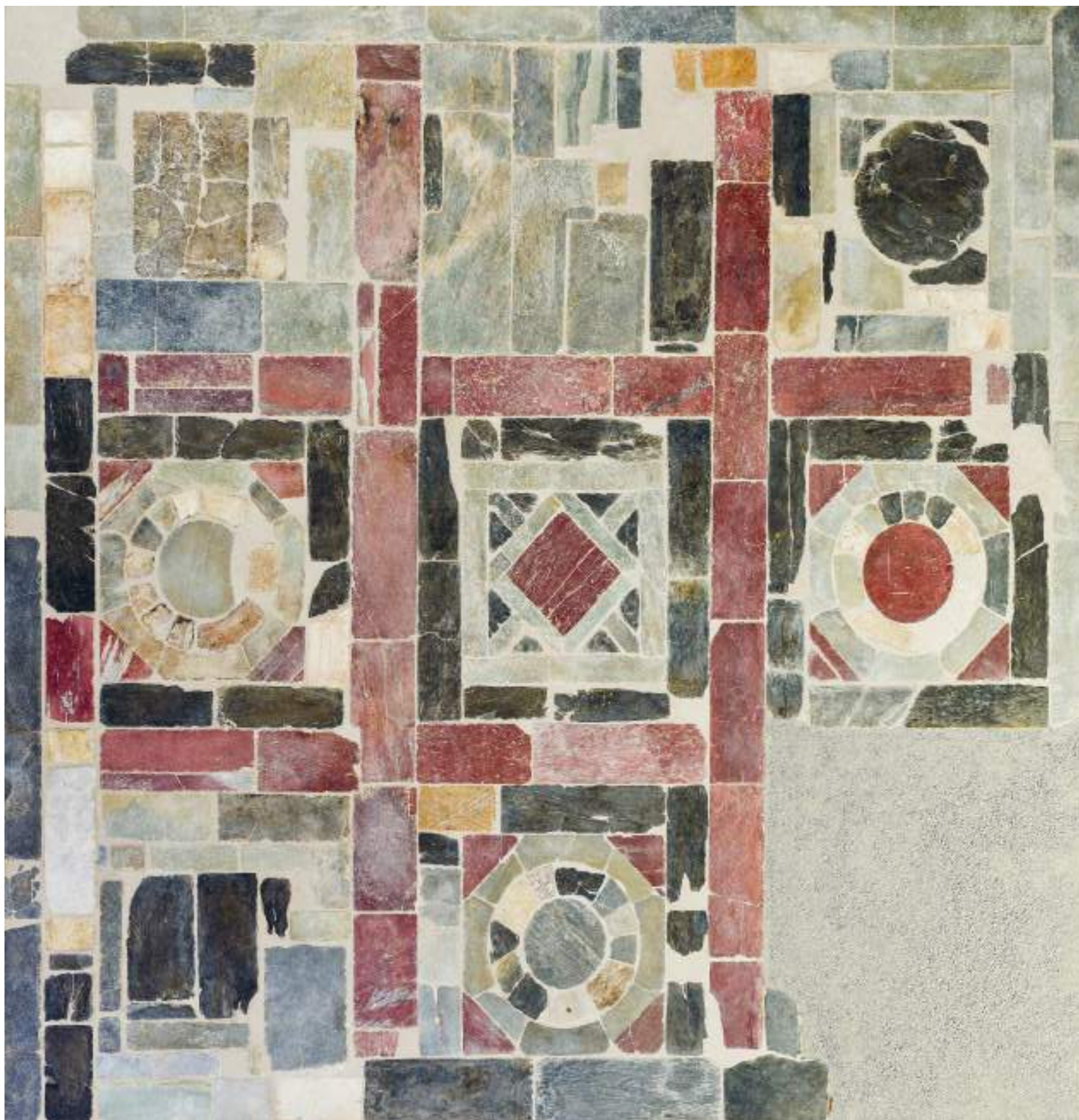
Τμήμα μαρμαρόστρωτου δαπέδου από πολυτελές δημόσιο λουτρό των υστερορωμαϊκών χρόνων. Πλάκες διαφορετικών μεγεθών και χρωμάτων σχηματίζουν γεωμετρικά διακοσμητικά θέματα σε πλαίσια διάχωρα. Πάτρα, 4ος αι. μ.Χ.
