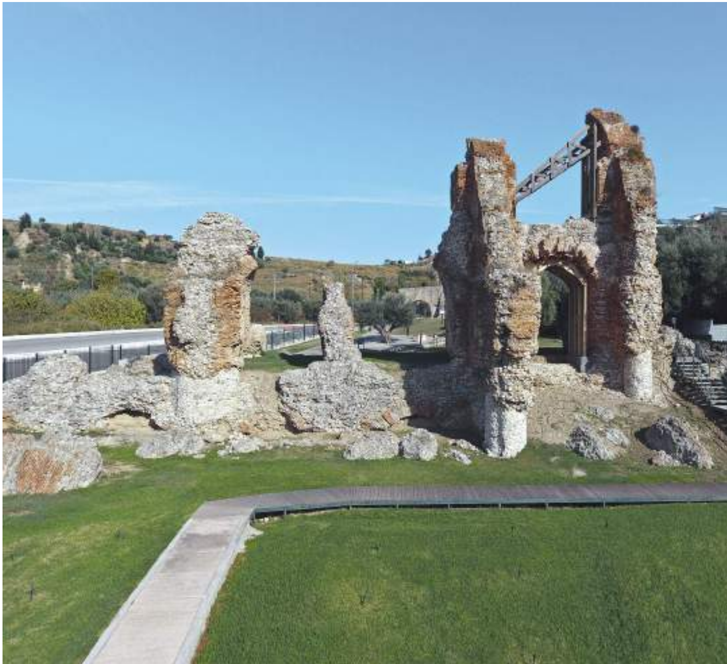
Μερική άποψη του αρχαιολογικού χώρου στην κοιλάδα της Αρόης, όπου διατηρούνται τα ερείπια της υψηλής υδατογέφυρας του ρωμαϊκού Υδραγωγείου (2ος αι. μ.Χ.). Ήταν κατασκευασμένη με τρεις επάλληλες σειρές τόξων κατά το ύψος και έφερε ισχυρές αντηρίδες.
