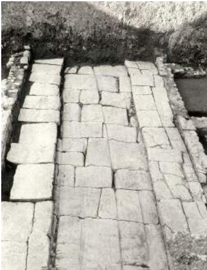
Τμήμα πλακόστρωτου ρωμαϊκού δρόμου. Χαρακτηριστικά είναι τα πεζοδρόμια και οι αύλακες των τροχάμαξων στο κατάστρωμα.
